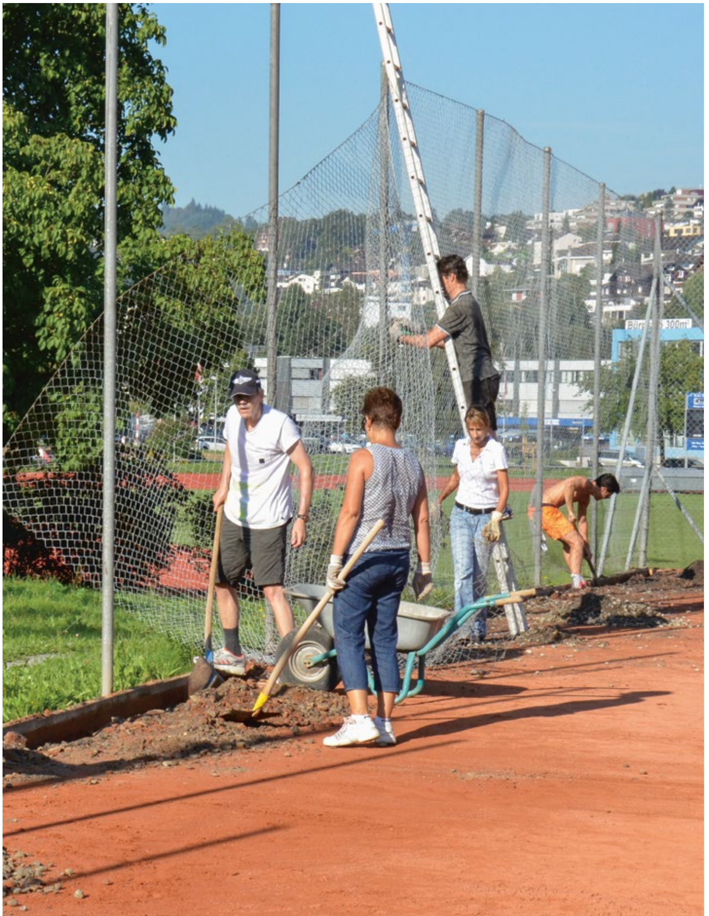
Als Tennisfamilie arbeiten wir tatkräftig für unseren gemeinsamen Erfolg, wie hier bei der Sanierung der Plätze 1 und 2 im Jahre 2015.
